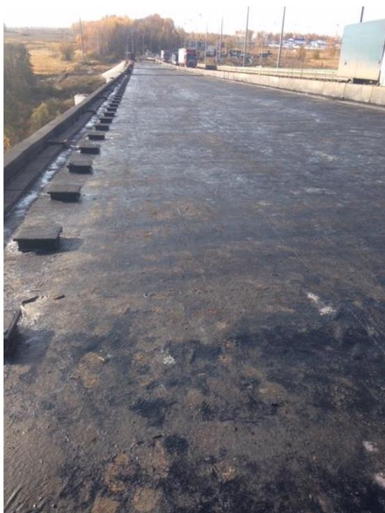
Этап 5- Укладку нижнего слоя покрытия проезжей части из асфальтобетона марки I непосредственно на гидроизоляцию Flexigum HP, армированную пропитанным геотекстилем, можно осуществлять через 24-36 часов после пропитки геотекстиля в зависимости от погоды и температуры воздуха.
