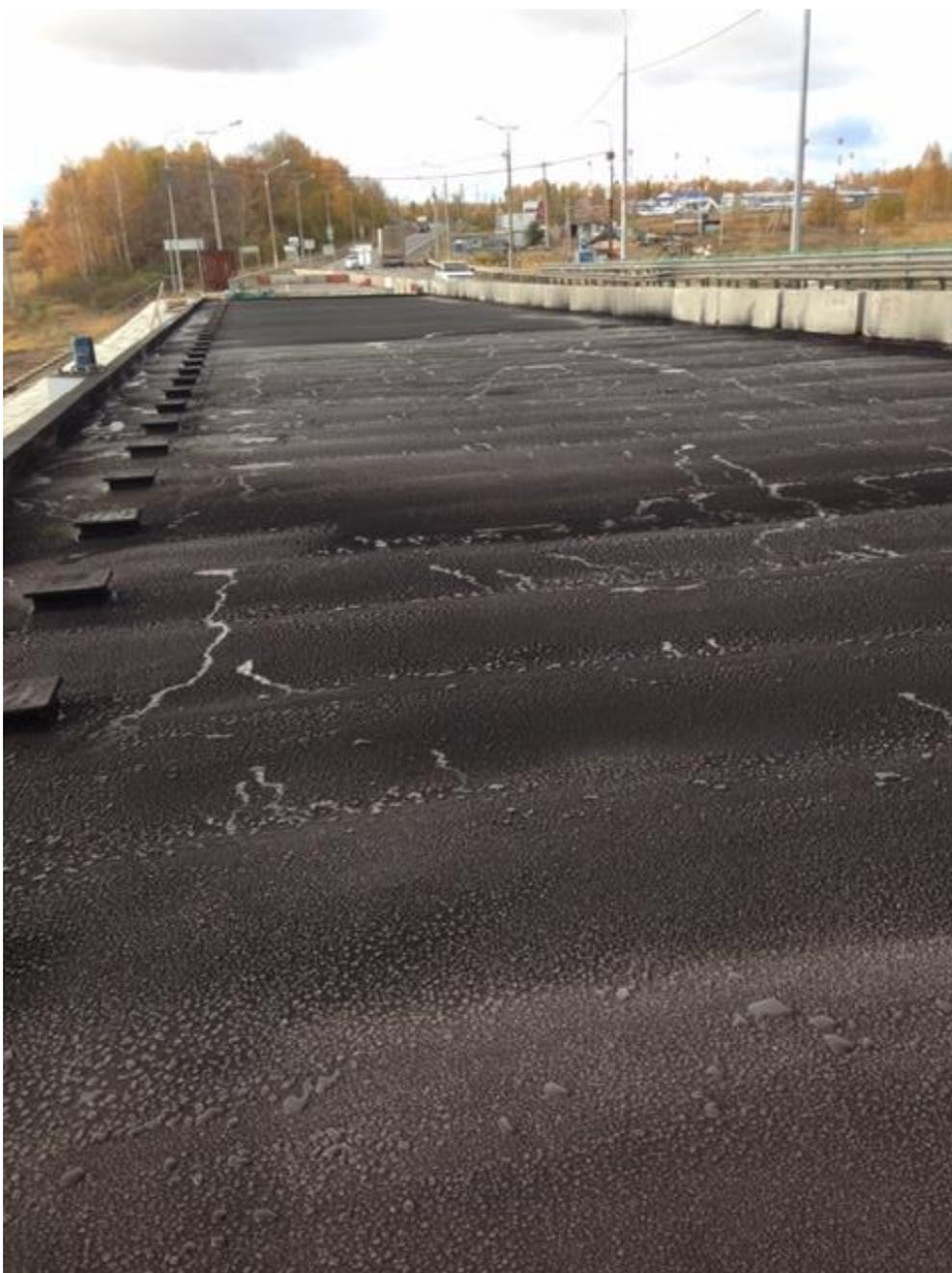
Мгновенно начинается процесс выделения технологической влаги, который продолжается в зависимости от погодных условий 24-36 часов. После выделения влаги гидроизоляционная мембрана Flexigum HP прилипает к основанию в каждой точке, образуя бесшовное сплошное покрытие. За одну рабочую смену можно напылить 1000-1200 кв.м. поверхности.
