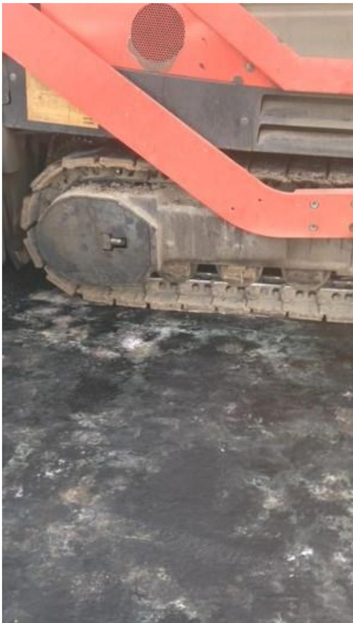
При прохождении подвозящей горячей асфальтобетон техники по гидроизоляционному ковру следует контролировать отсутствие протечек соляры, бензина и трансформаторных масел, так как мембрана Flexigum HP не стойка к действию вышеуказанных жидкостей в силу битумной природы состава Flexigum HP.
